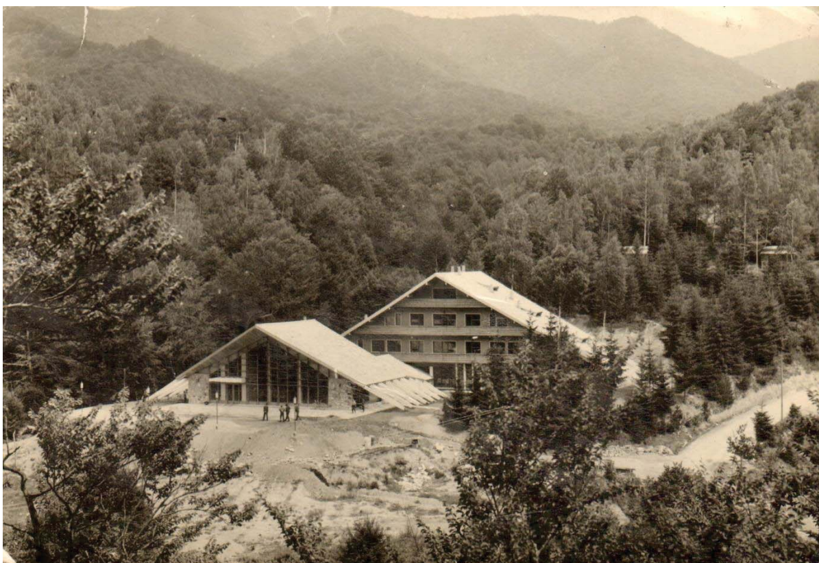
Хотел „Шатор“ на Јастрепцу, Историјски архив Крушевца (н.д.)
