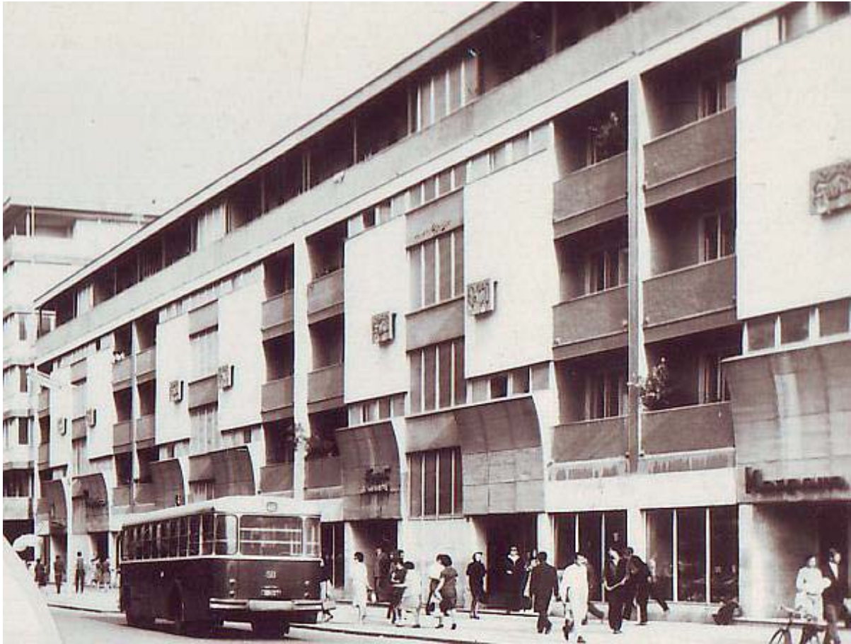
Стамбена зграда, фото-документација Друштва архитеката Ниша (н.д.)
